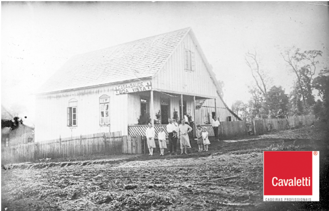
Casa de Saúde Boa Vista, primeiro hospital de Erechim construído em 1926, na rua Itália, número 225. Fonte: Acervo fotográfico Arquivo Histórico Municipal Juarez Miguel Illa Font. Mais informações sobre esta foto ou algum registro histórico para compartilhar envie para: regiao@jornalbomdia.com.br .
