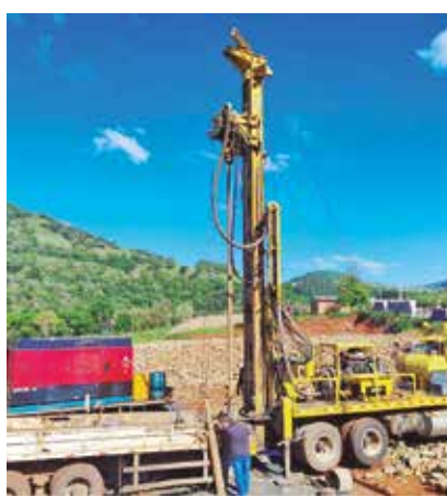
Estrutura alcança 370 metros de profundidade e reforça a segurança hídrica do município
