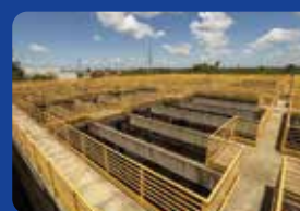
ESTAÇÃO DE TRATAMENTO DE ESGOTO
