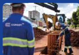
OBRA DE REDE DE ESGOTO
